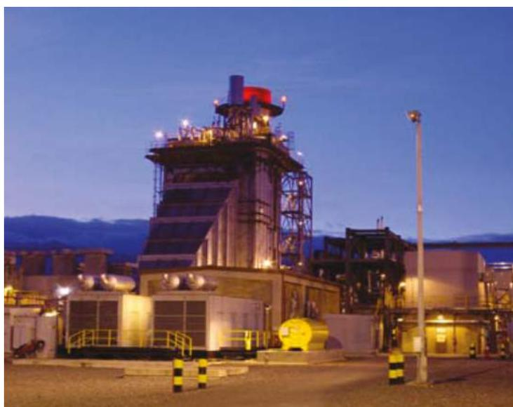
Termoemcali es la generadora térmica de mayor capacidad efectiva en la región Suroeste, 229 MW. Por su condición de planta dual participa en el mercado de gas natural y, al tiempo, posee contratos en firme para el suministro y transporte de diésel, todo esto con el fin de obtener un costo de energía competitivo que le permita entrar en el despacho centralizado.
