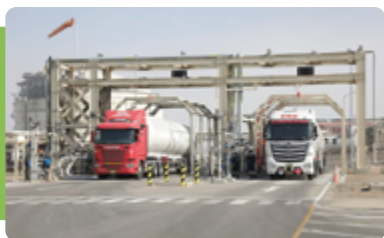
Nuevo cargadero de GNL en Pampa Melchorita
