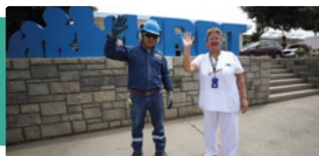
Instalación de gas natural en el Hospital Regional Docente de Trujillo
